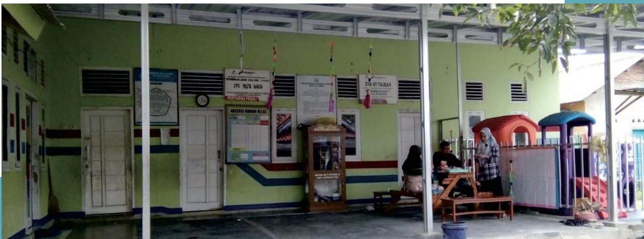
Kondisi DTA setelah di Renovasi
