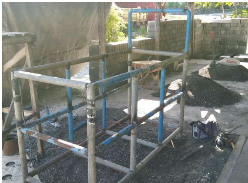
Gambar 4. Pembuatan rangka hanging reef
