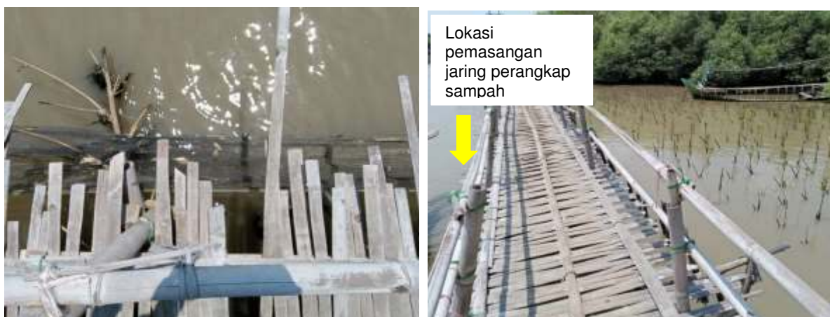
Gambar 2. Jaring perangkap sampah terpasang di bawah jembatan jalur tracking Mangrove (kiri), Jaring Perangkap sampah melindungi sampah masuk ke areal penanaman mangrove (Kanan)
