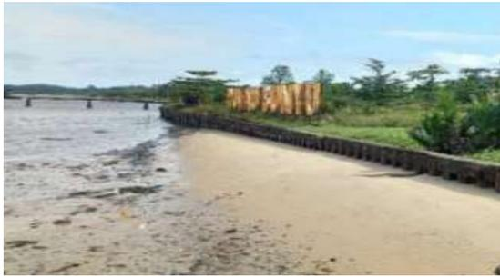
**Gambar.** *Steel sheet pile sea-wall* pencegah abrasi pantai di pesisir pantai Desa Bunyu Barat
