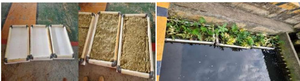
**Gambar.** Pembuatan rangka modul meraki (kiri) dan Implementasi modul meraki di bak sedimentasi IPAL domestik (kanan)
