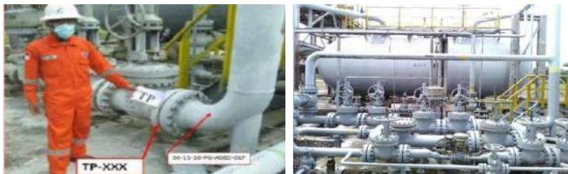
**Gambar.** Lokasi tie in point dari PG Gas ke jalur fuel gas system (kiri) dan rekayasa jalur pada outlet PG Gas KO Drum (kanan)
