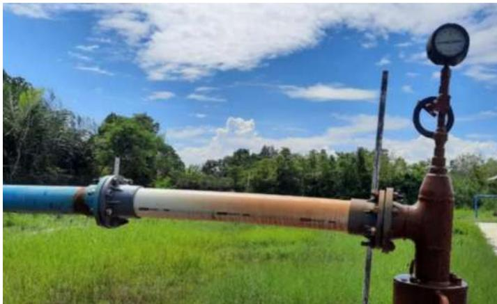
**Gambar.** Dokumentasi Restriction Orifice pada Water Well (AROWW)
