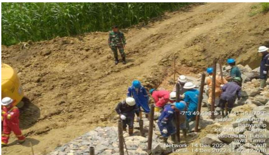
**Gambar.** Perbaikan jalan rusak akibat adanya tanah longsor
