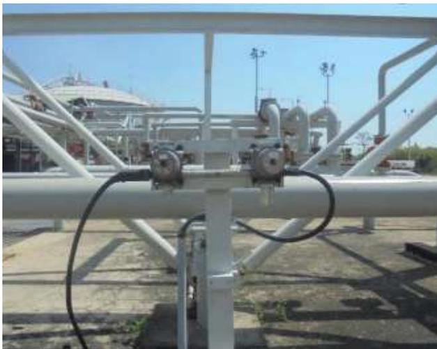
**Gambar.** Pemasangan H<sub>2</sub>S gas sensor
