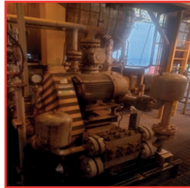
Gambar 66. Modifikasi Pemasangan Oil Deflector pada Glycol Pump Seal
