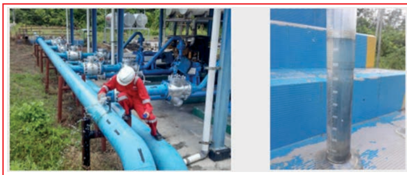
Gambar 133. Modifikasi Alat Injeksi Chemical Demulsifier dan Deoiler
