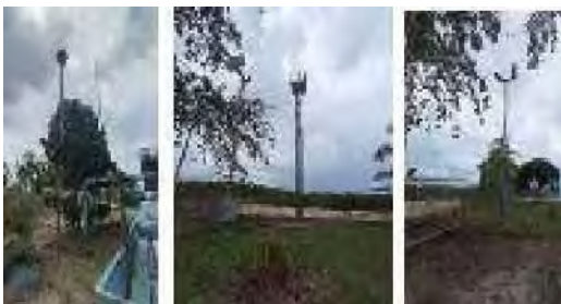
Gambar. Pemasangan early warning system oleh PHE Kampar
