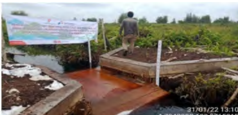
Gambar. Dokumentasi Pembangunan Sekat Kanal Kayu dan Sekat Kanal Terpal
