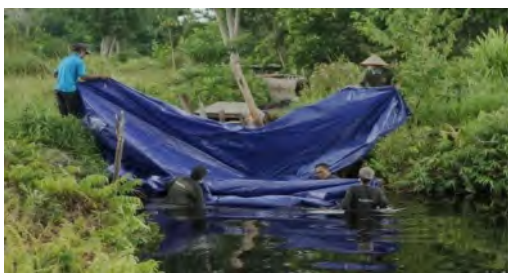
Gambar. Pembuatan Sekat Kanal di Dusun 7 Desa Muara Medak
