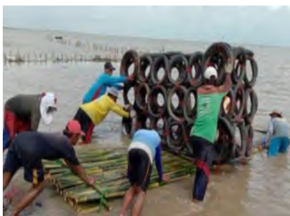
Gambar. Pemanfaatan limbah ban bekas menjadi penahan gelombang
