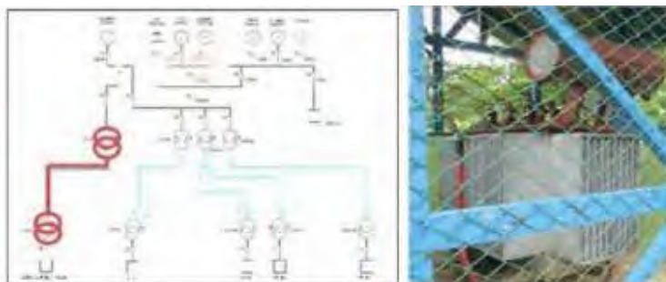
Gambar. Dokumentasi Program Optimasi Water Injection Plant (Penggantian Jaringan Listrik Power Plant - WIP Dari 400 V Ke 6600 V)
