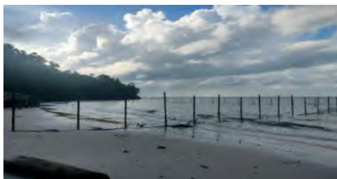
Gambar. pemasangan tiang pancang penahan abrasi di Pantai Tanjung Arang
