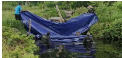
Gambar. Dokumentasi Pembangunan Sekat Kanal Kayu dan Sekat Kanal Terpal
