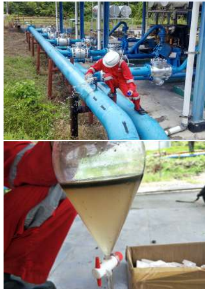
Gambar 26 Dokumentasi Program Deoiler penurunan Oil Content
