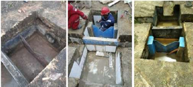
Gambar 20 Dokumentasi Program MANTAV (Pemanfaatan Besi Bekas Untuk Pembuatan V - Notch)
