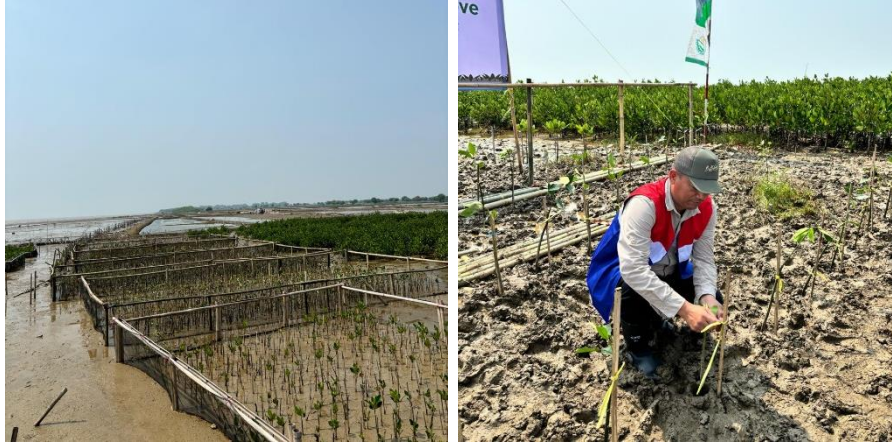
Gambar 2. Penerapan Inovasi Pagar Tonggak Bambu dengan menanam Rhizophora mucronata secara sistem cluster, berjarak, dan pemasangan tonggak dan pagar pelindung.
