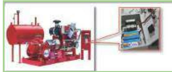
Gambar 8. Inovasi Alat Automatic Charging pada Accu Fire
