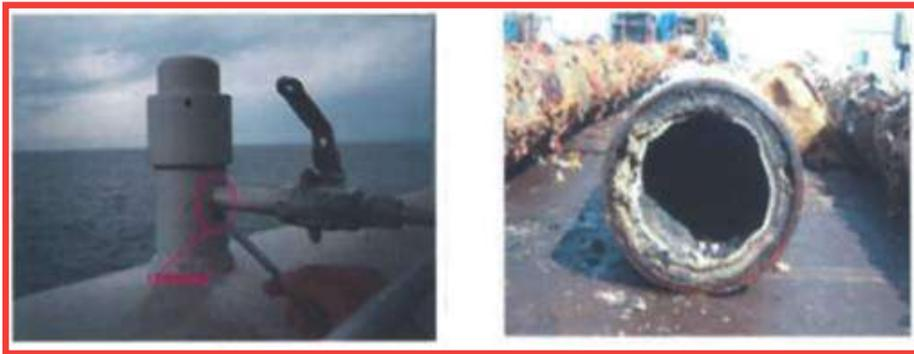
Gambar 84. Titik Injeksi dan Contoh Kebocoran pada Pipa serta Keadaan Pipa Sebelum Progres TEE LESS
