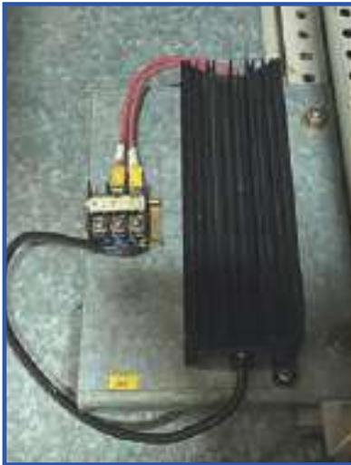
Gambar 39. Modifikasi HVAC Switchgear Panel di MCC Heater
