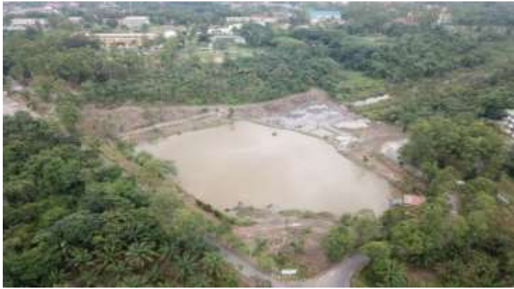
Gambar 7. Lokasi pembangunan ecoriparian pada tahap persiapan lahan
